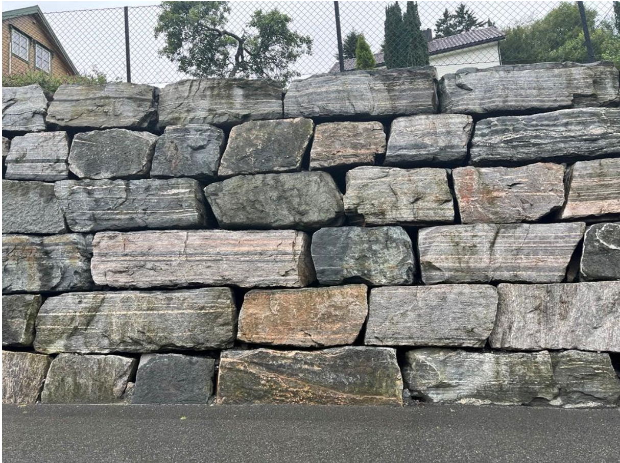
Figur 1: Muresteinsmur i Fosnavågen. Legg merke til det stripete utseendet til blokkene. Blokkene er splittet langs de stripete lagene – langs spaltepplanet.
