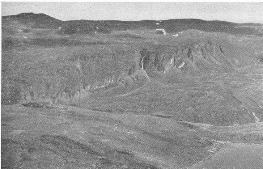
Fig. 58. Distance view of the eastern wall of upper Kåfjorddalen. Sabetjok mine lies at the top of scree fans on either side of the waterfall. Birtavarre Høyfjell working lies up on the plateau behind, and to the left of, Sabetjok. (Photo P. Parget.) Østveggen av Øvre Kåfjorddalen. Sabetjok gruve ligger ved toppen av urene på begge sider av fossen. Birtavarre Høyfjell skjerp ligger på platået bak og til venstre for Sabetjok. (Foto P. Padget.)
