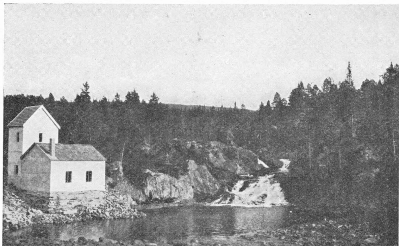
Fig. 22. Killingdal grubes nye kraftstasjon.
